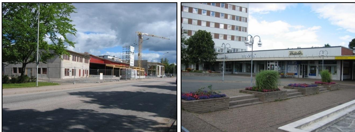
Byggandet av Kulturhuset/skolan pågår för fullt. Kronogårds torg idag.
